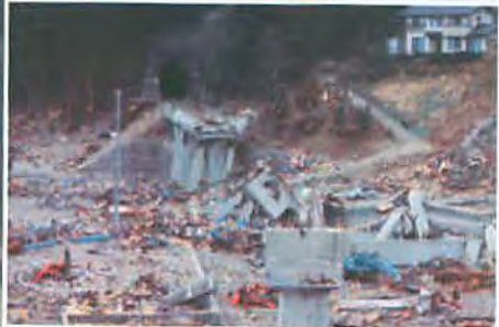
島越駅駅舎とホーム
